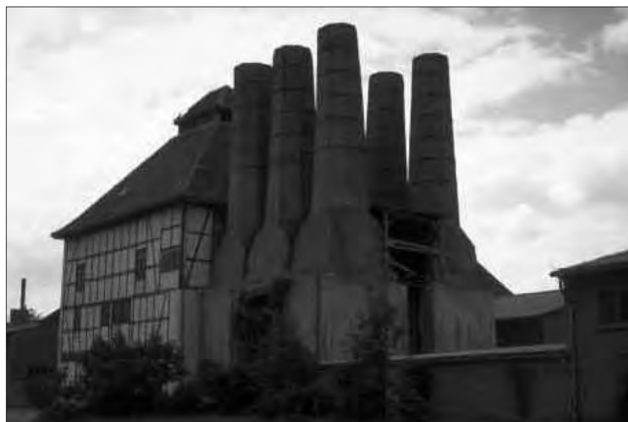
Kalkbrennanlage in Erxleben
