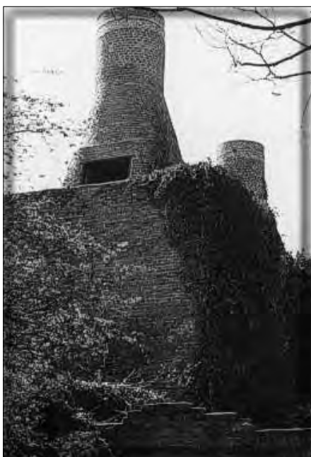
Kalkbrennanlage in Stadtlohn
