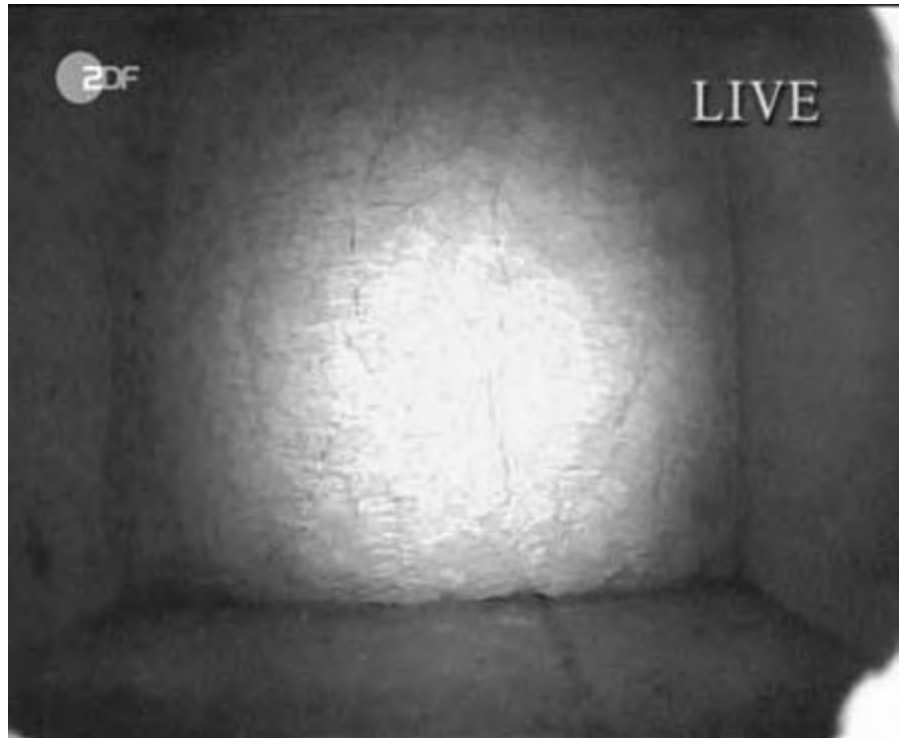
Der Verschlussstein hinter dem Verschlussstein. Gerade noch erkennbar sind die seitlichen Begrenzungen, aus denen erkennbar ist, dass der Hohlraum den Maßen des „Luftschachtes“ entspricht. Am Boden ist eine Kerbe oder Vertiefung erkennbar.
