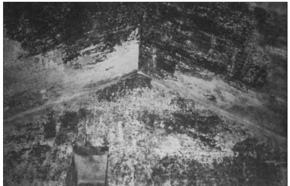
Die „Königinkammer“ befindet sich im genauen Schnittpunkt der Großen Pyramide und hat eine giebelförmige Deckenkonstruktion. Blick auf die östliche Wand mit einer Nische (Eickhoff)
