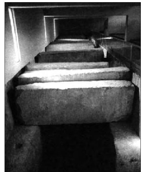
Granitriegel einer „Überlastungskammer“
