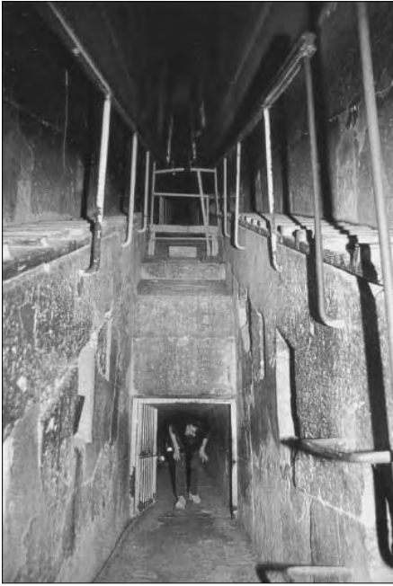
Der Durchgang zur Königinkammer befindet sich an dem Punkt, wo der aufsteigende Gang in die Große Galerie übergeht.
