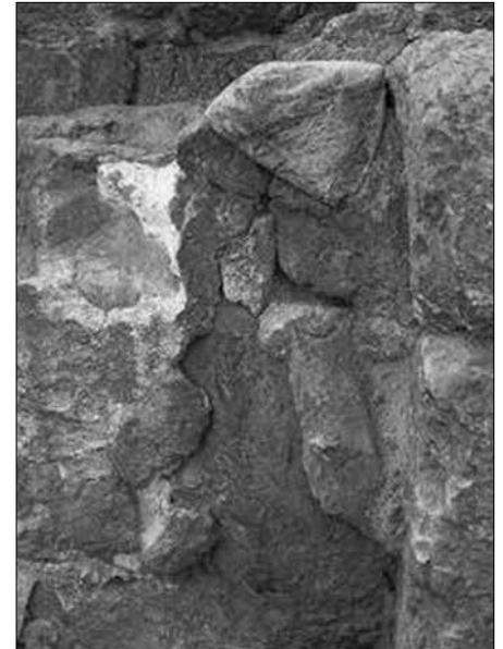
Abb. 5 (links) - Völlig unregelmäßige Verlegung an der Cheopspyramide. Abb. 6 (rechts) - Antike Mörtelfüllung zwischen den Blöcken, Cheopspyramide.
