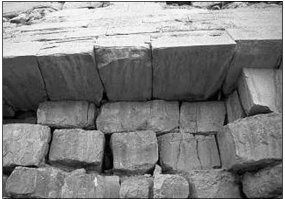
Abb. 4 - Unregelmäßige Blöcke an verwitterungsgeschützter Stelle, Knickpyramide (Dahshur).
