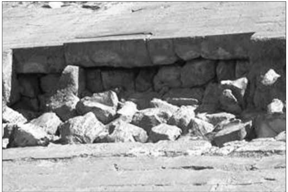
Abb. 2 - Unregelmäßige Blöcke unter dem Stufenmantel in Meidum.
