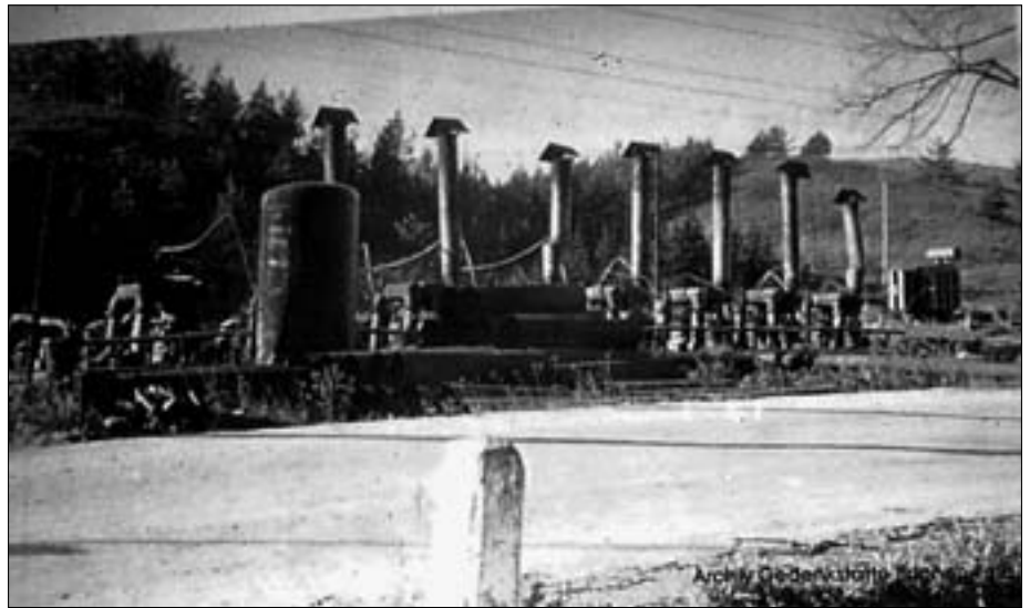
Kompressorenstation. So sah die Station 1945 aus. Bild aus dem Museum des Jonastalvereins.
