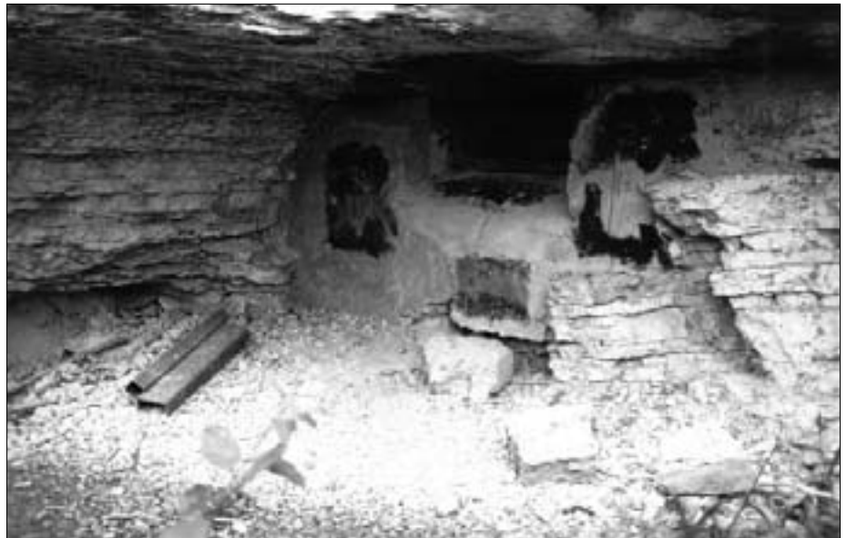
Zubetonierter Stolleneingang.
