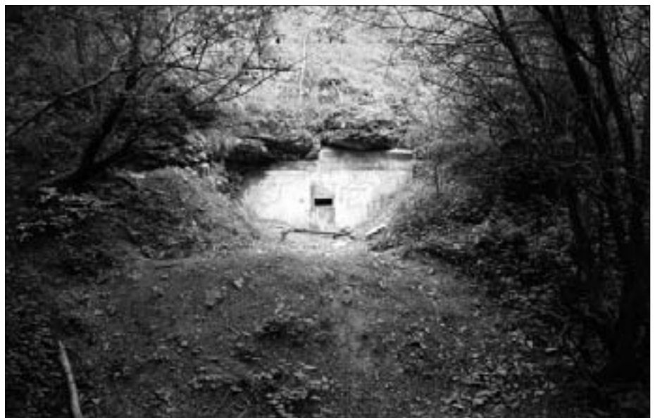
Betonierter Zugang mit Flugöffnung für Fledermäuse.
