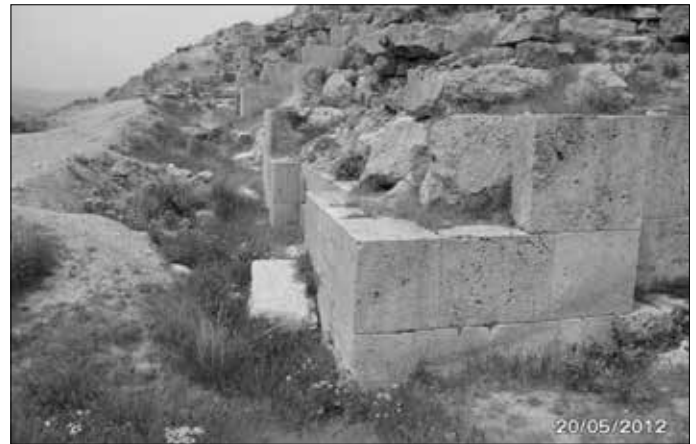
Bild 6: Mauer, aus tadellos rechtwinkligen Quadern hergestellt.
