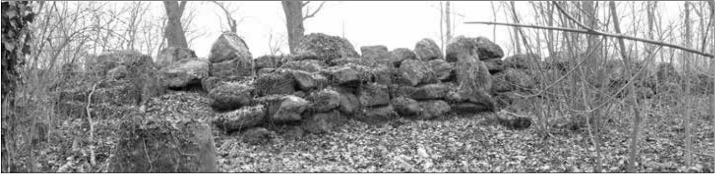
Abb. 18: Seitenansicht der Rampe auf dem Teufelsberg.
