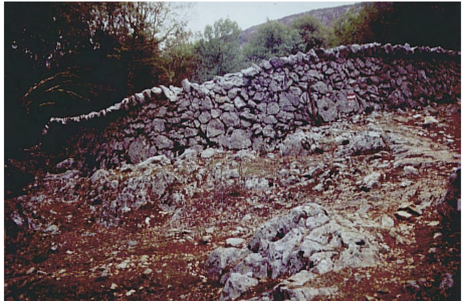
Bild 1: Keltische Mauer, nach außen übergekragt.
