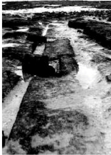
Gleise bei Cádiz
