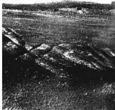
Gleise auf dem flachen Vorland von Termest
