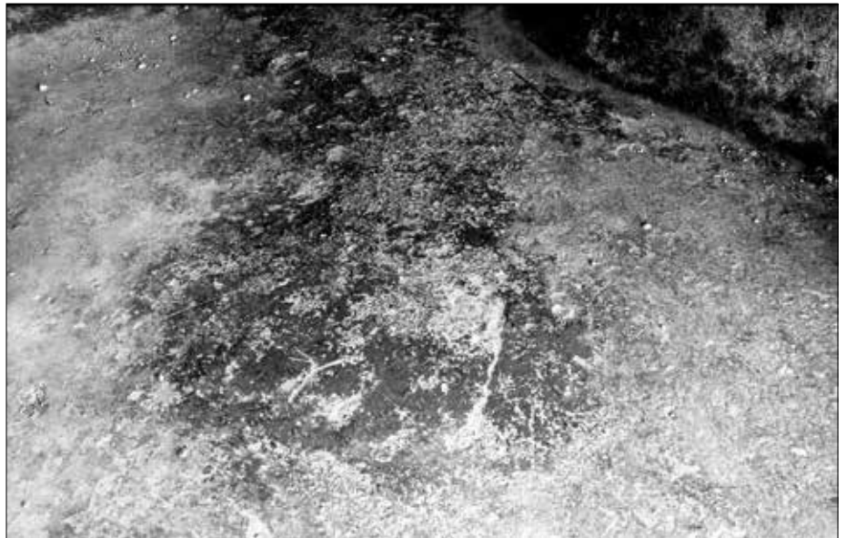
Bild 9: Nahaufnahme des Fußbodens.
