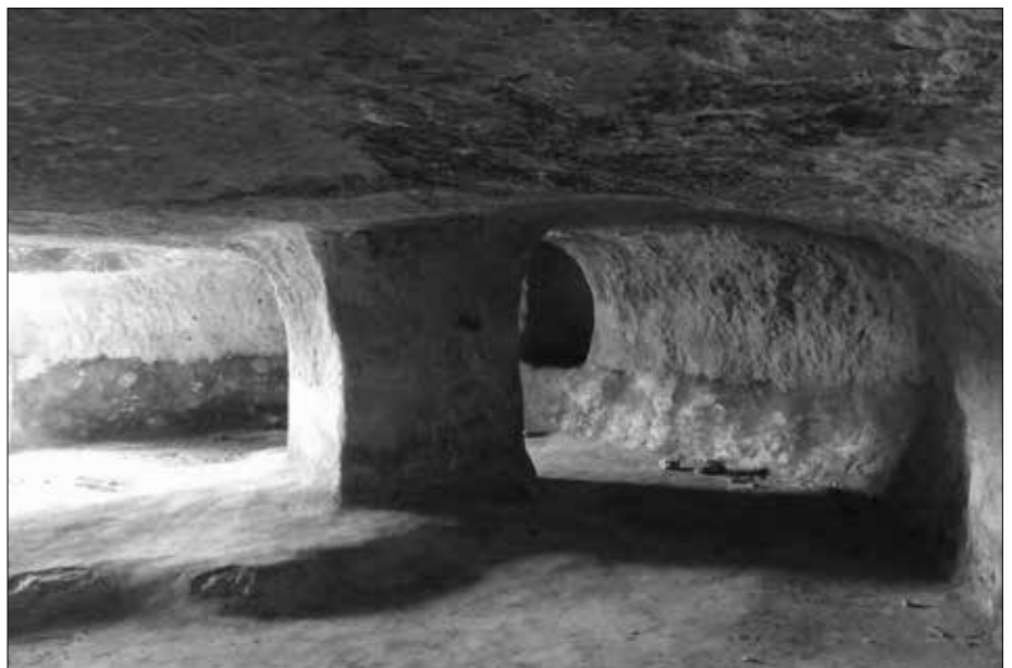
Bild 10: Algenschicht an der Wand.
